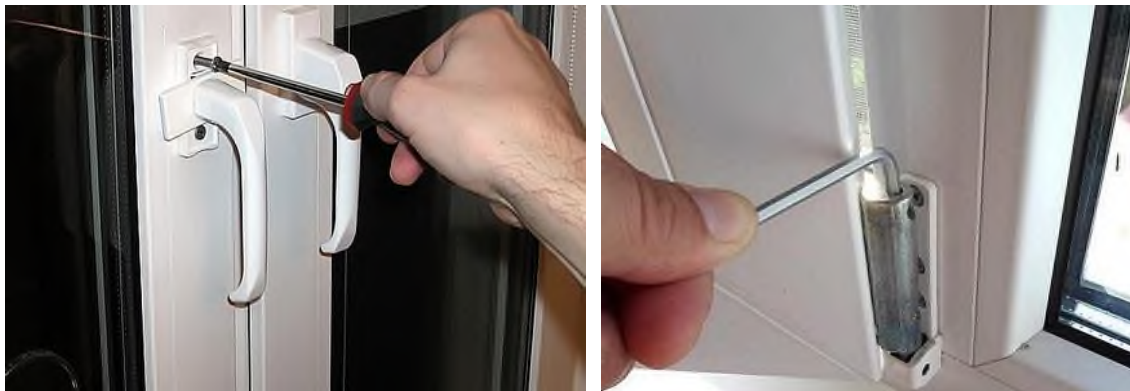
Рисунок 14. Регулировка пластиковых окон
