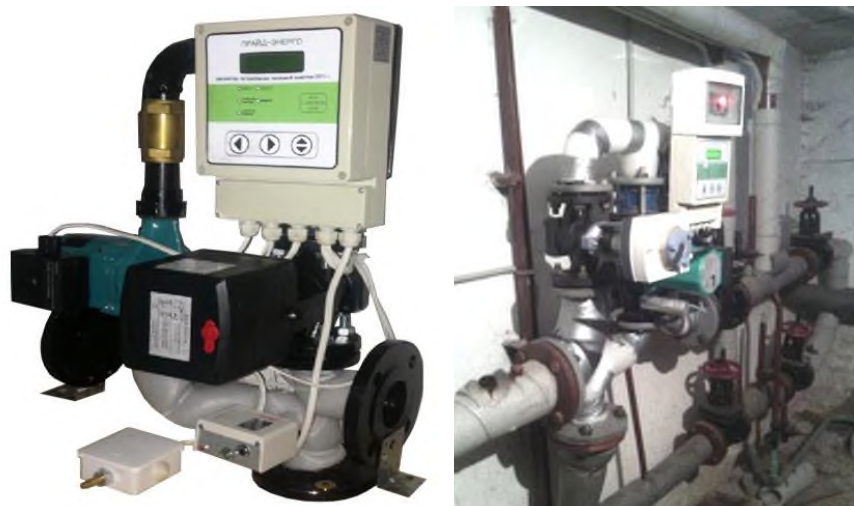
Рисунок 10. Внешний вид и пример монтажа СУАПР
